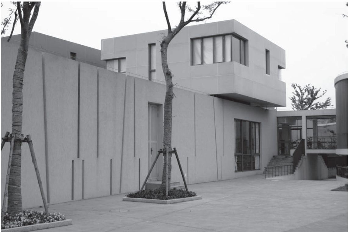
École maternelle à Qingpu (Shanghai) par Liu Yichun, Chen Yifeng et Zhuang Shen (Agence Deshaus). © Françoise Ged.
