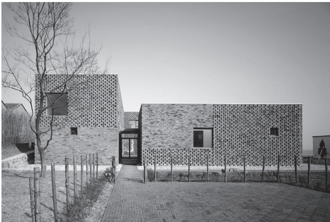
Maisons des poètes à Gaochun (Jiangsu) par Zhang Lei (Atelier Zhang Lei). © Nacasa Et Partners.
