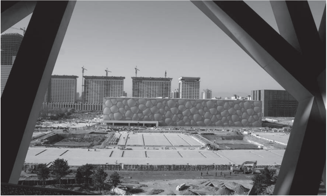
Piscine olympique à Pékin par l'agence PTW Architects. © Françoise Ged.
