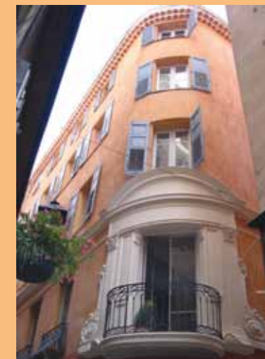
↑ Réhabilitation en logements de l'ancien magasin des Dames de France, rue Marcel Journet.
