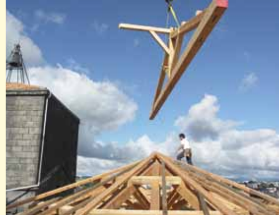
↑ Restauration de la toiture de la Halle aux Bleds, pose de la charpente.
