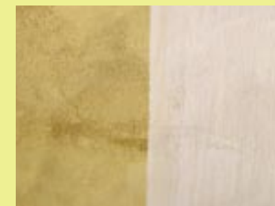
↓ Détail de badigeon de chaux sur enduit lissé.
