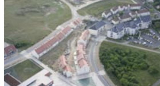
Vue des Aigremonts, en cours de construction en 2006.
