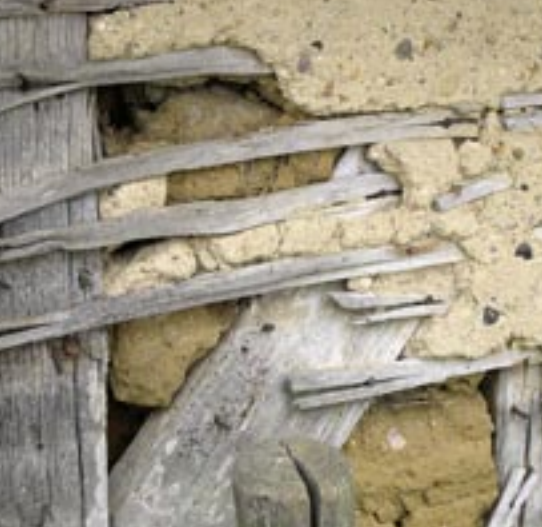
← Détail de mise en œuvre du torchis sur lattis.
