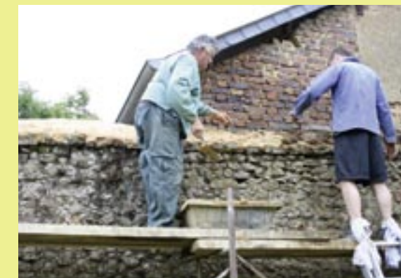
↑ Restauration d'un mur d'enceinte.
