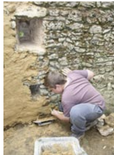
← Réalisation d'un enduit à la chaux aérienne naturelle.
