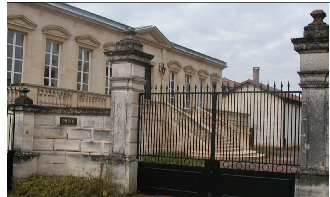
La grille d'entrée du château La Tour Figeac (Saint-Emilion) et ses lourds piliers de pierre de taille, typiques du style de la fin du XIXe siècle.
