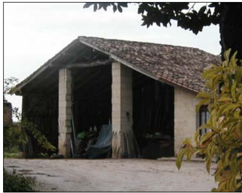
Quelques hangars traditionnels, à piliers de pierres, charpente bois et couverture tuile canal.
