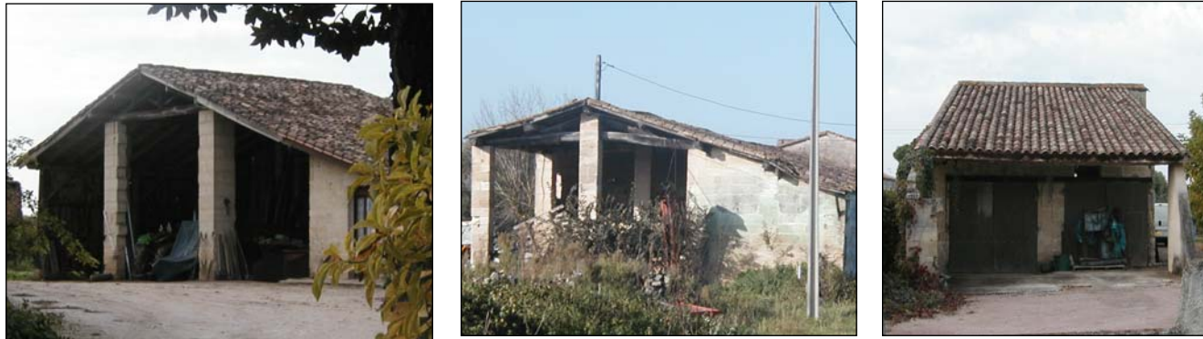
Quelques hangars traditionnels, à piliers de pierres, charpente bois et couverture tuile canal.
