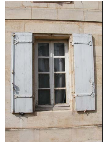
Une fenêtre banale, à linteau droit, on notera les volets pleins avec leurs pentures de fer forgé ouvragées ainsi que la crémone.
