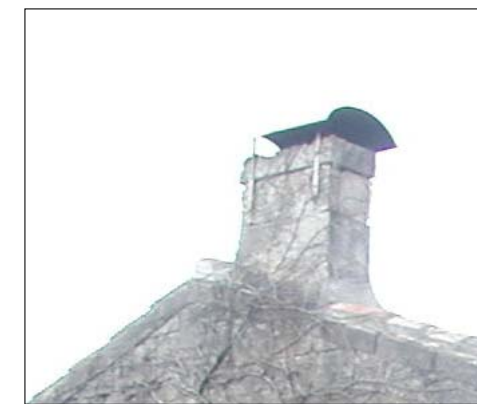
souche de cheminée en pierre de taille et détail d'une tôle mobile arrondie en zinc (protection contre la pluie). D'après Doyon et Hubrecht, p. 160.
