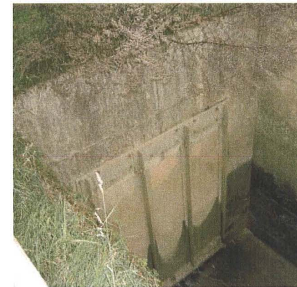
Exutoire du réseau de drainage
