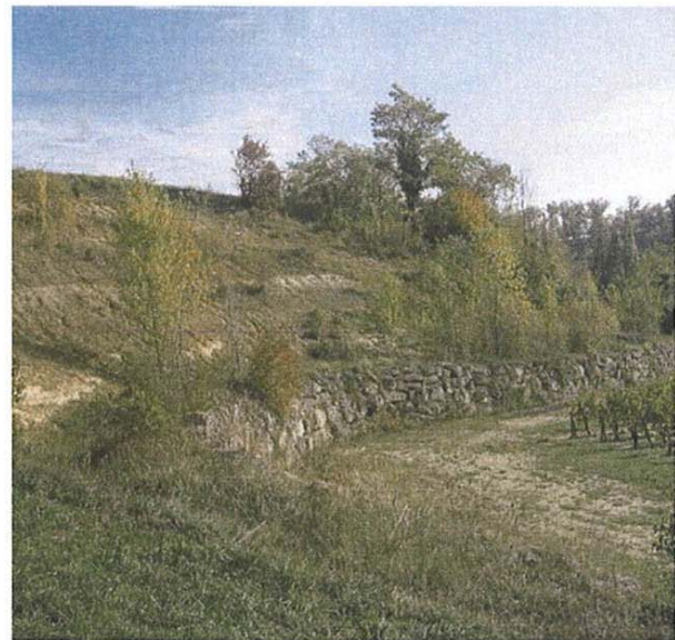
Terrassement en enrochements
