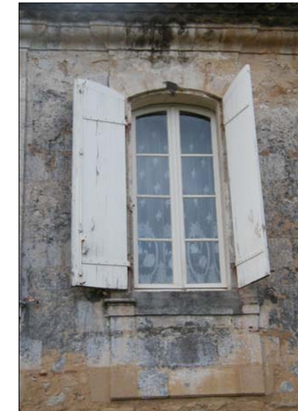
Une fenêtre XVIIIe, à arc segmentaire, un léger ressaut du nu de façade la rejoint à la corniche et en marque l'appui.
