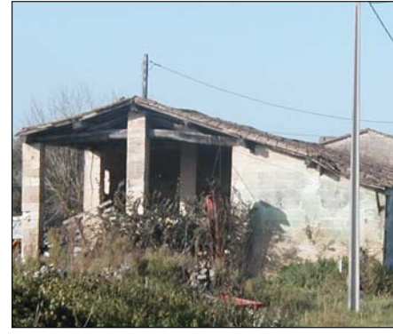
Quelques hangars traditionnels, à piliers de pierres, charpente bois et couverture tuile canal.
