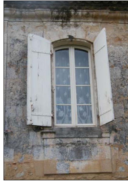
Une fenêtre XVIIIe, à arc segmentaire, un trumeau en léger ressaut la rejoint à la corniche et en marque l'appui.
