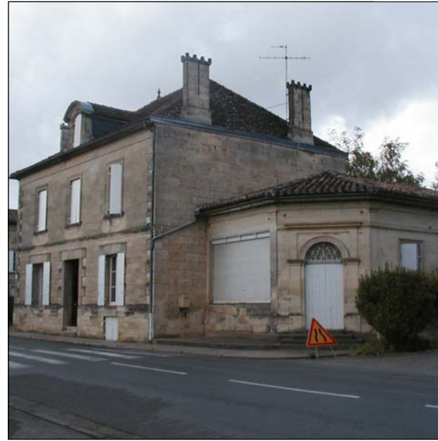
Au coeur du bourg de Saint-Christophe, une lourde maison de pierre de taille aux chaînages d'angle marqués s'impose à l'angle de la rue principale et d'une rue secondaire. Ses chiens assis au fronton arrondi et ses hautes cheminées saillantes permettent de la dater de la fin du XIXe siècle.
