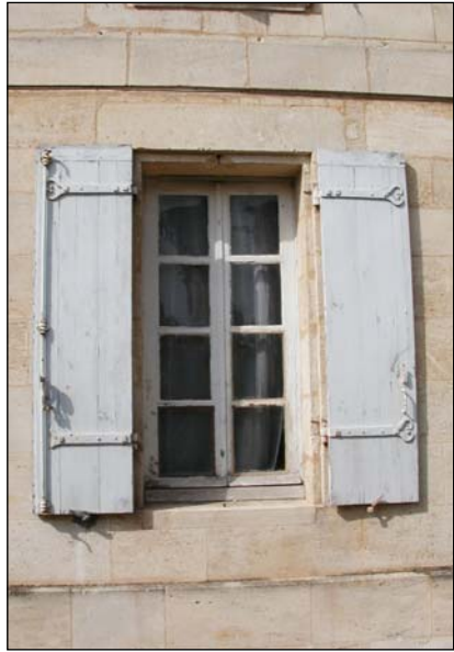
Une fenêtre banale, à linteau droit, on notera les volets pleins avec leurs pentures de fer forgé ouvragées ainsi que la crémonne.
