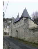
Hôtel de Chauvigny rue Buffon
