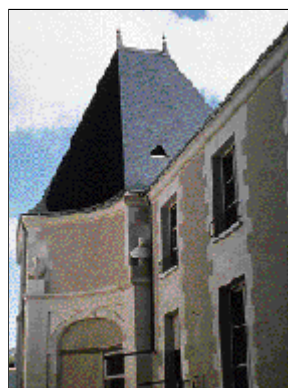
et après restauration
