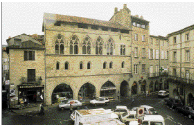
L'immeuble après restauration
