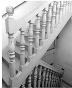
escalier rampe sur rampe
