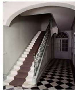
escalier à jour central (volées droites)
