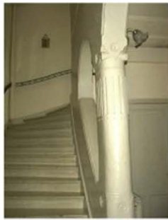
escalier à mur d'échiffre ajouré
