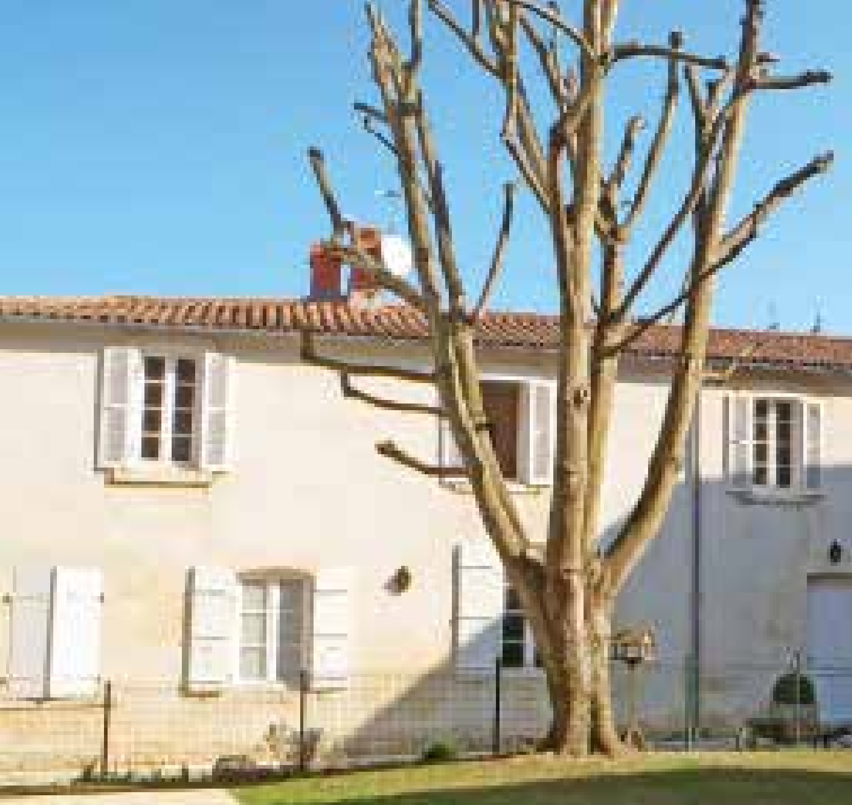
L'aile nord-ouest de l'hôpital Saint-Honoré qui devrait accueillir le futur CIAP
